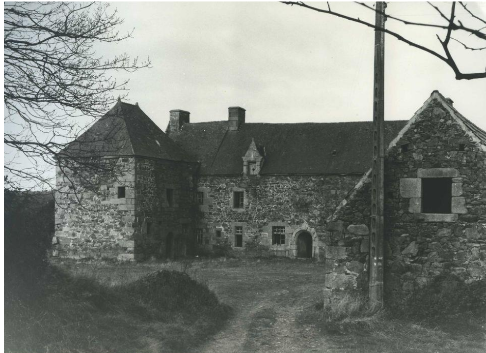
Manoir de Kerprigent : ensemble sud, vue générale
